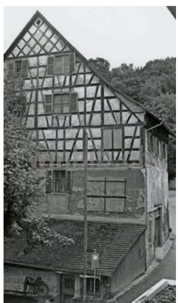
Die Hofstadlerscheune vor dem Umbau 1979.
